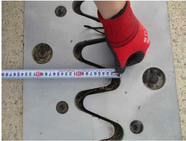
신축이음 유간거리 측정
