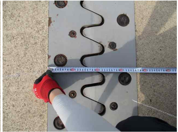
신축이음 유간거리 측정
