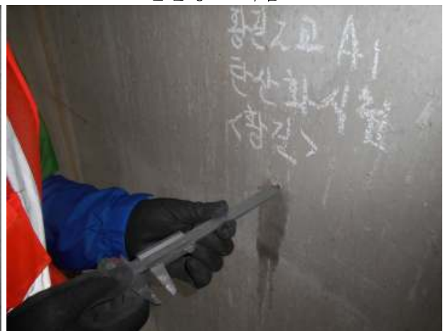
콘크리트 탄산화시험(탄산화 깊이측정)
